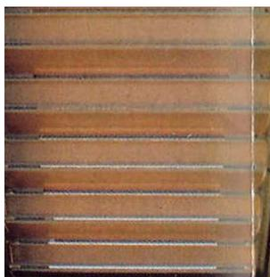
**Fentes d'aération et d'éclairage indirect** entre toutes les lamelles. Aucune fente n'est visible de l'extérieur.
